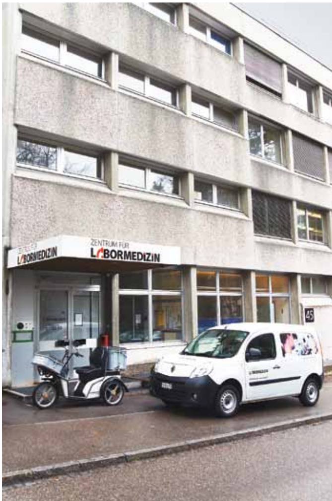
Zentrum für Labormedizin Standort: Frohbergstrasse 3, Haus 45
